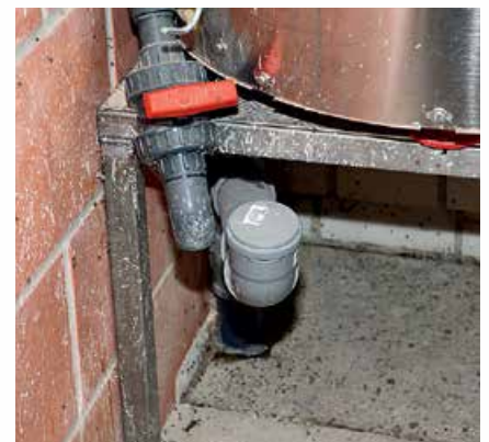
Damit der Behälter per Wasserschlauch leicht und gründlich zu reinigen ist, installierte der Landwirt einen schwenkbaren Ablauf mit Geruchsverschluss.
